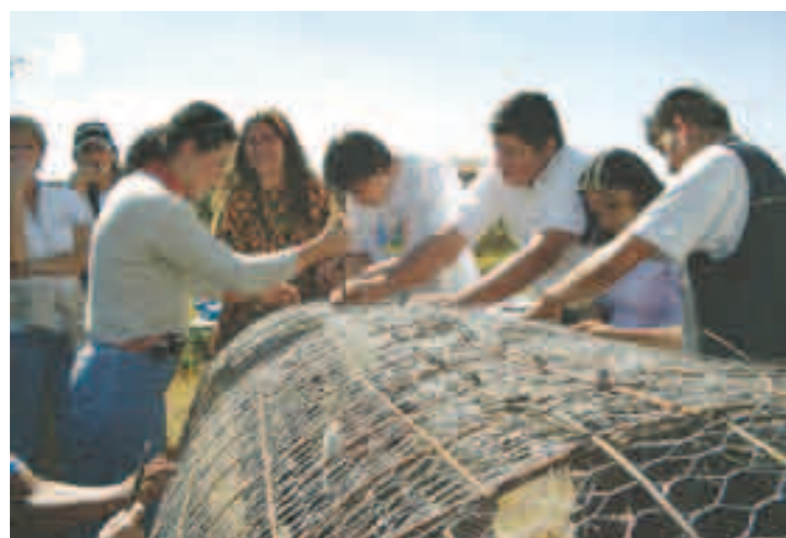
Construcción de biodigestor en Michoacán
