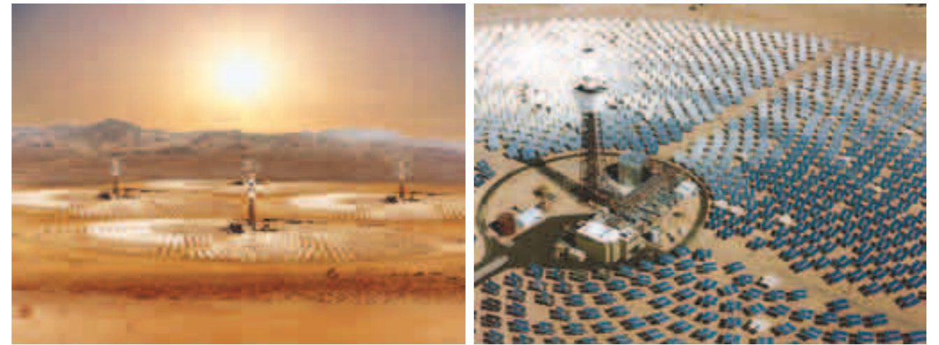
Planta solar generadora de electricidad
