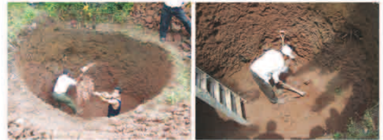
Construcción de cisterna de ferrocemento
