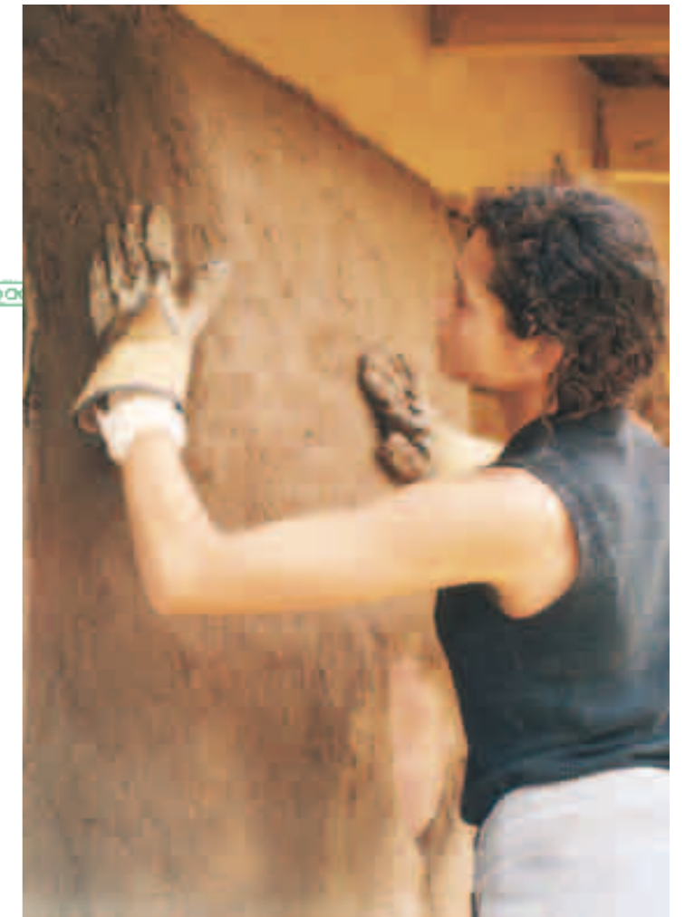
Construyendo con técnica Cob
