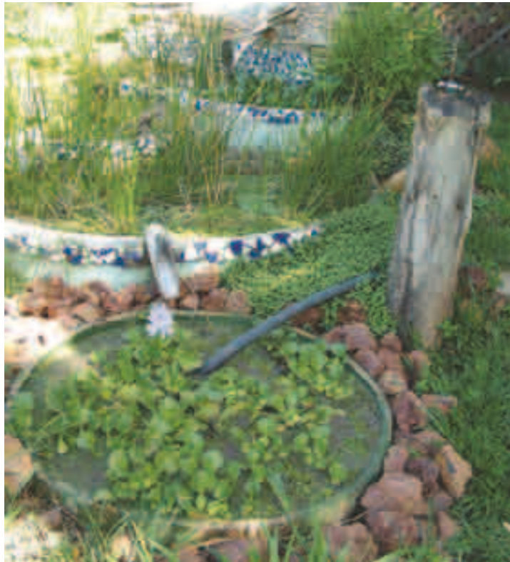
Sistema de tratamiento de aguas grises
