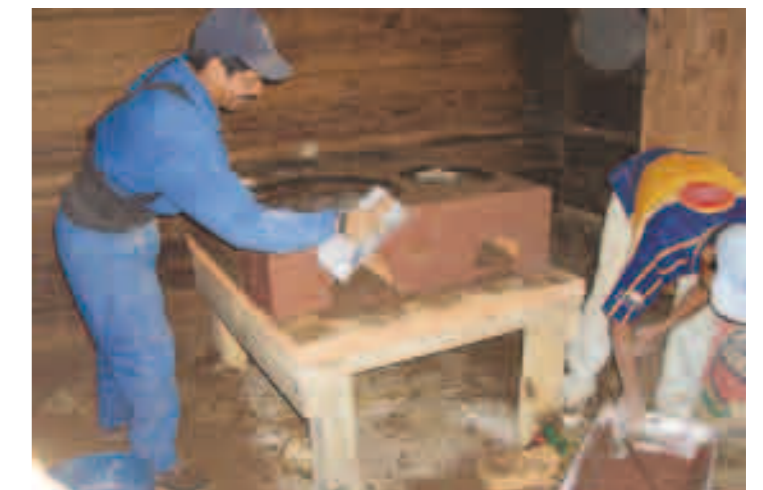
Construcción de estufa Patsari
