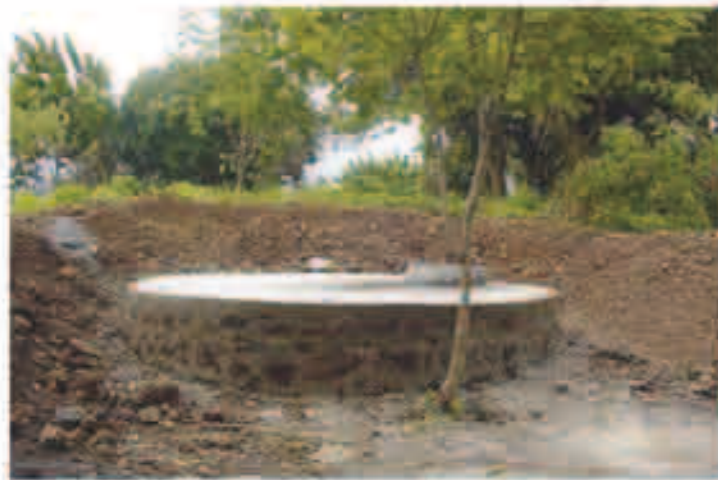
Cisterna de ferrocemento
