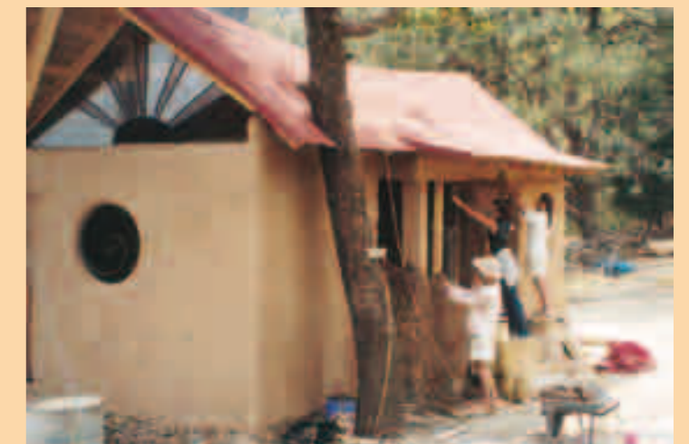
Construyendo con tierra y paja
