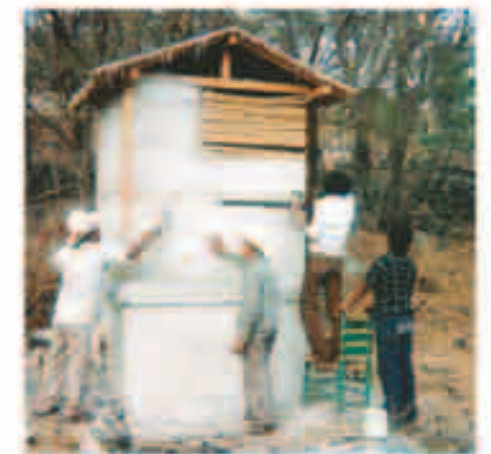
Construcción de un sanitario
