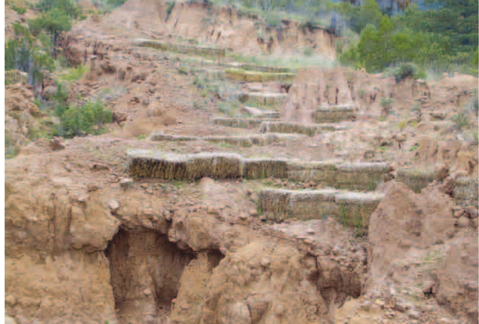
Restauración de cárcavas con pacas de paja
