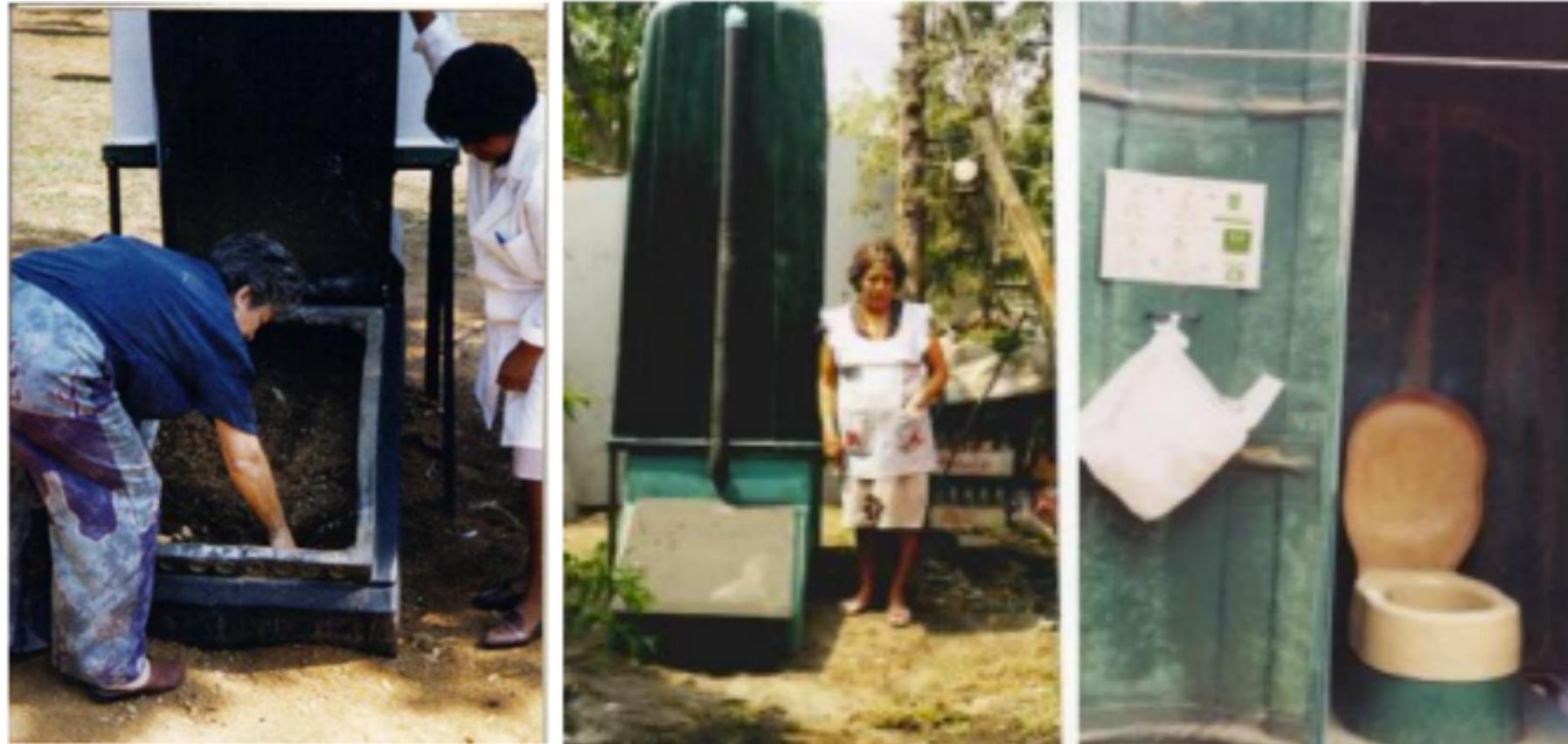
Sanitario ecológico para el procesamiento de desechos orgánicos sólidos. Cascarón con piso integrado y excusado, manufacturado con 35 Kg de polietileno roto moldeado en horno. Colector solar de policarbonato de alta densidad 62 x 76 x 6mm, ventila de hojalata de 3" diámetro.
